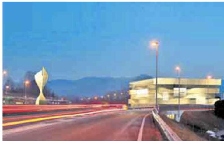
Sulla sinistra la scultura architettonica pensata dall'artista Paolo Selmoni, alta quasi 25 metri, che legherà le aree nord e sud fra loro. Scultura che diverrà pure il portale d'accesso del Centro Servizi (a destra nella foto) per i fruitori provenienti da sud.
